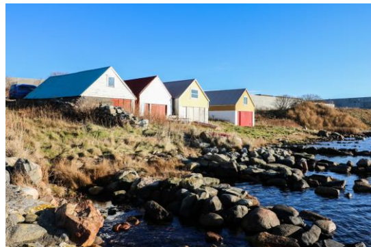
Naustbebyggelse Brunnavika (Sola kommune).
