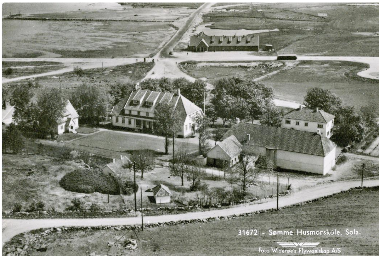
Sømme husmorskole, ukjent dato, trolig fra begynnelsen av 50-årene (foto Widerøe flyveselskap, mottatt fra Solabladet)
