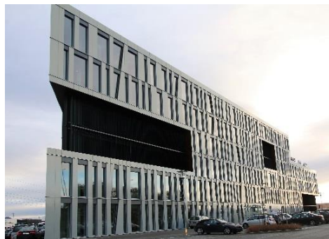
Kontorbygg Apply (Sola kommune)
