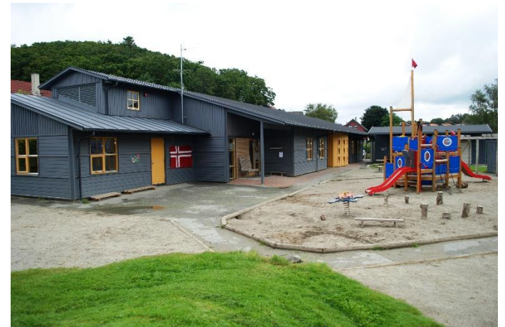
Bygg Øygarden, Øygardsletta 13
